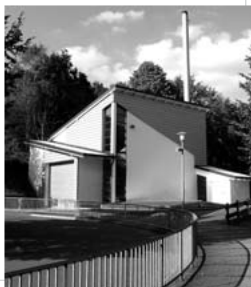
Das Biomasseheizwerk auf dem Schulgelände
